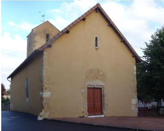
Façade occidentale rénovée en 2009 Porte flamboyante à accolade et blason nu
