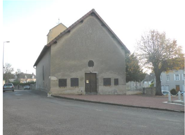
Façade avant rénovation avec les plaques de cheminées
