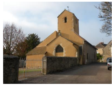
Depuis la rue de l'église, derrière le mur, le chevet et la fenêtre, la tour-clocher à bâtière et son escalier d'accès.
