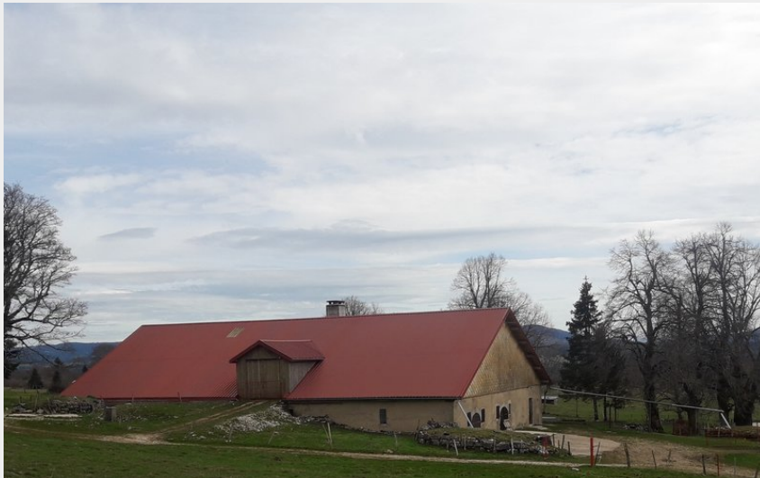
Grange des Miroirs depuis la Route du Grand Taureau (CCGP)
