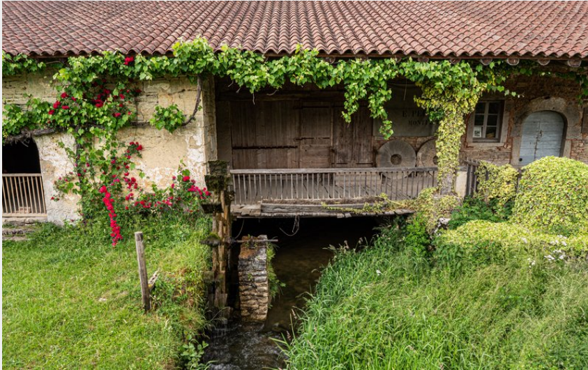
Moulin Pont des Vents (OT Clairvaux-les-Lacs)
