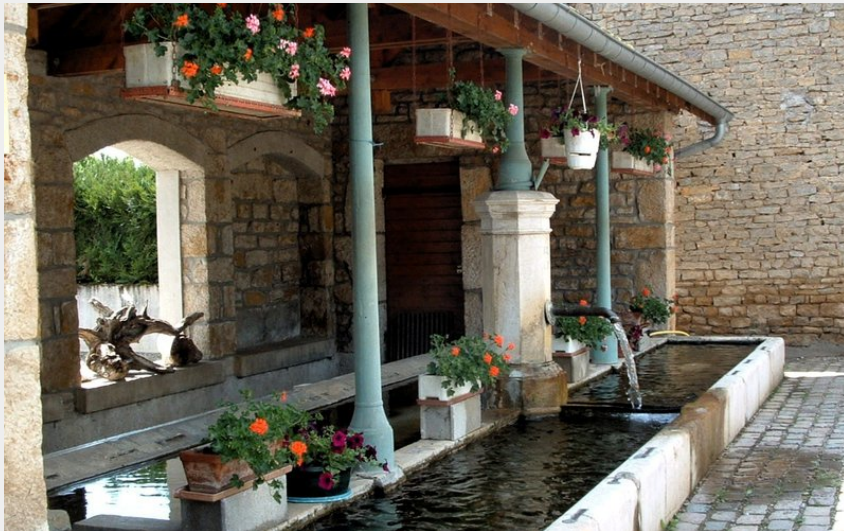
Lavoir de Franey (OT Val Marnaysien)
