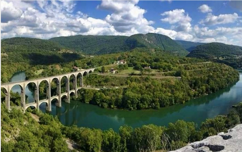
viaduc de Cize
