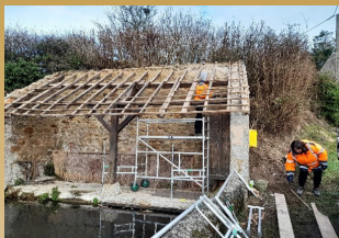
Réfection du toit du lavoir de La Vallée du Haut
